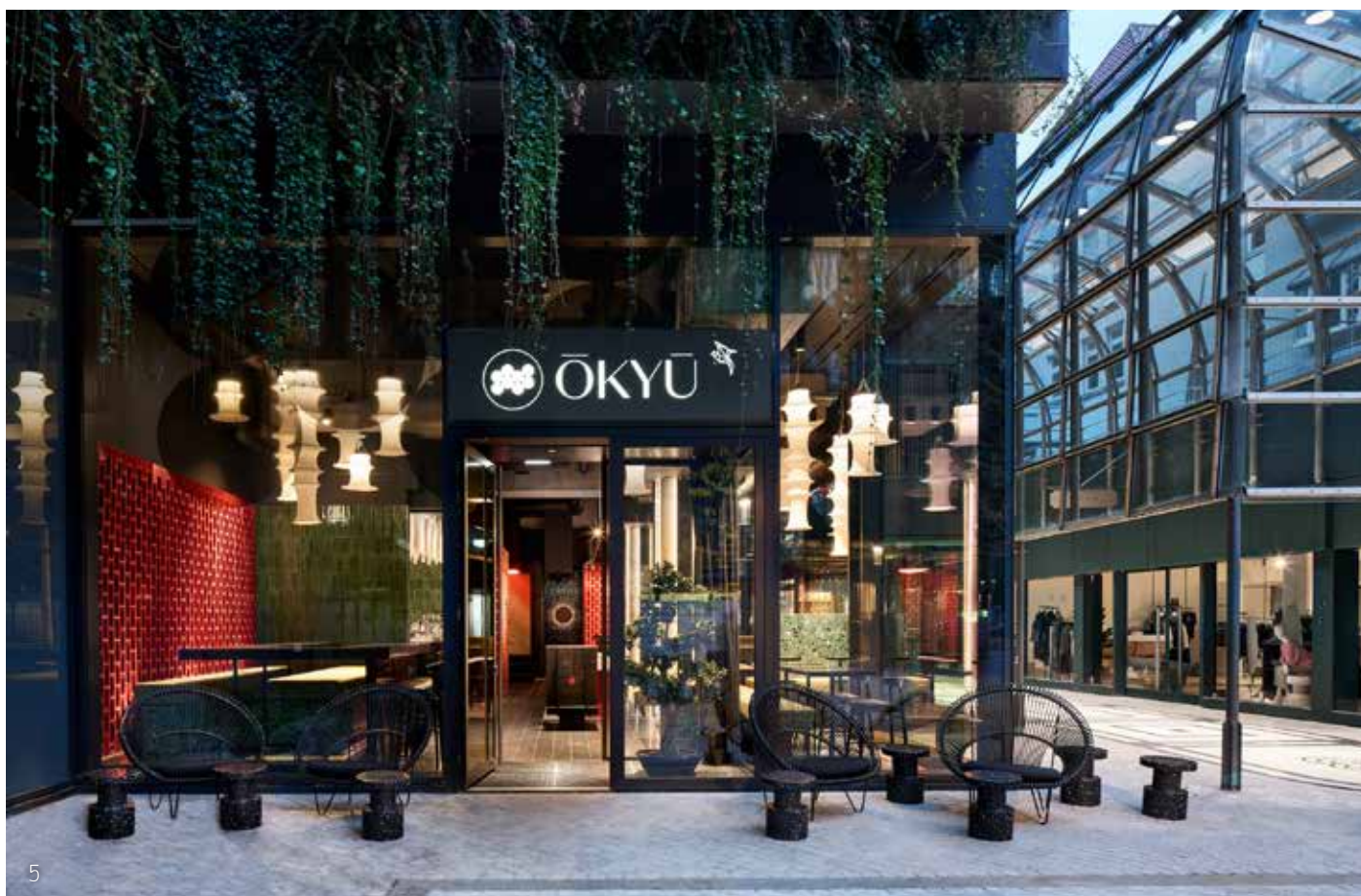
Abbildung 5: Die Außenfassade des Ökyü glänzt durch eine begrünte Fassade und bietet somit einen Mehrwert fürs Klima.
